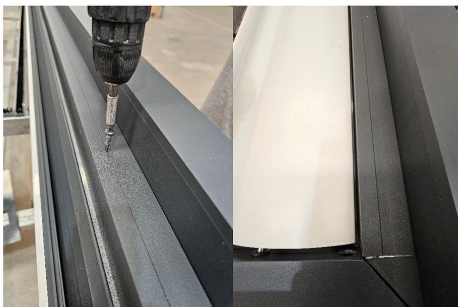
18. Le moteur est livré déjà posé sur la poutre et avec la visse de fixation à la lame déjà en place. Retirez l'écrou autobloquant et insérez la vis dans l'embout de la lame.
