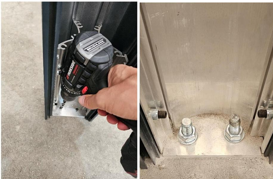
10. **REMARQUE** : Attention à la position des poteaux, en particulier du poteau électrique, afin que les trous de fixation correspondent et que les composants électriques soient proches des fils de connexion.
